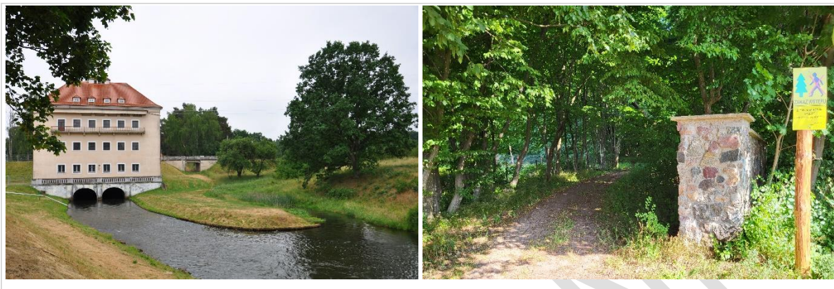
Fot. 4. Widok na zabytkową elektrownię wodną w Krzynie
