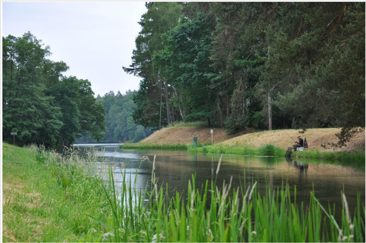
Fot. 3. Widok na kanał doprowadzający wody Stupi ze zbiornika zaporowego Krzynia
